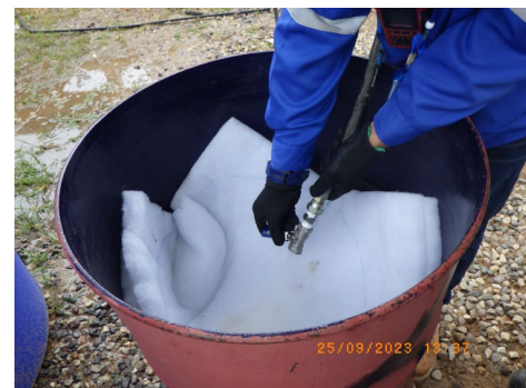
ภาพที่ 2-10 การกรองน้ำทิ้ง Hydrostatic Test
