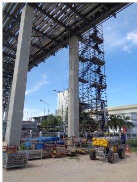
ภาพที่ 2-40 การติดตั้งนั่งร้าน
