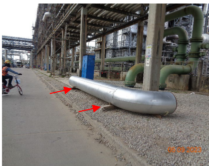
ภาพที่ 2-33 วัสดุที่ใช้ในการวางท่อบริเวณพื้นที่เก็บท่อ เพื่อป้องกันการพังทลาย อาทิ ลิ่มไม้
