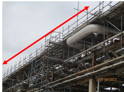
ภาพที่ 2-41 การติดตั้งอุปกรณ์กันตก เช่น ราวกันตก แผ่นกันตก นั่งร้าน ตาข่าย
