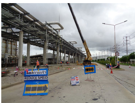
ภาพที่ 2-11 การกั้นเขตพื้นที่ก่อสร้างออกจากเส้นทางจราจร
