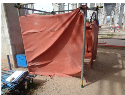
ภาพที่ 2-44 โครงสร้างเหล็ก (Pipe camp) ไม่กระดานปูพื้น ผ่ากันไฟ สำหรับงานเชื่อม
