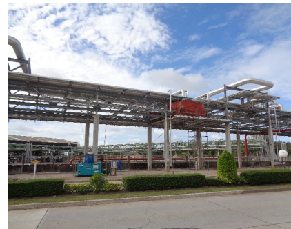
ภาพที่ 2-43 การป้องกันท่อส่งก๊าซฯ และระบบสาธารณูปโภค ข้างเคียงบนโครงสร้างชั้นวางท่อ (Pipe rack)
