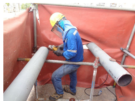
ภาพที่ 2-44 โครงสร้างเหล็ก (Pipe camp) ไม่กระดานปูพื้น ผ่ากันไฟ สำหรับงานเชื่อม
