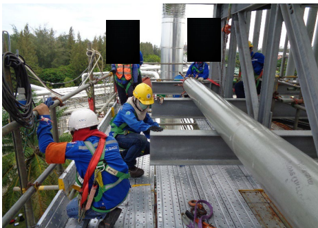
ภาพที่ 2-42 พนักงานสวมใส่และใช้อุปกรณ์ป้องกันการตก
