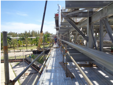
ภาพที่ 2-17 การจัดเก็บท่อบนชั้นวางท่อ (Pipe Rack) เพื่อไม่ให้กีดขวางจราจร
