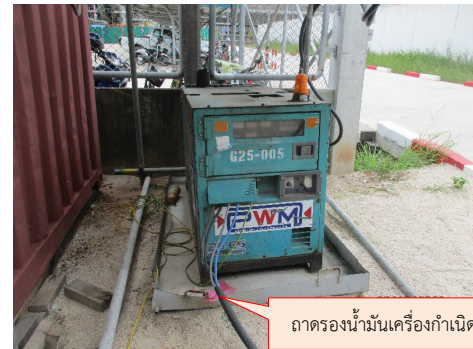
ภาพที่ 2-8 อุปกรณ์ป้องกันการรั่วไหลของน้ำมันและสารเคมี จากยานพาหนะและอุปกรณ์ก่อสร้าง
