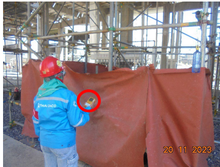
ภาพที่ 2-36 เครื่องมือตรวจจับก๊าซในพื้นที่ปฏิบัติงาน (Gas Detector)
