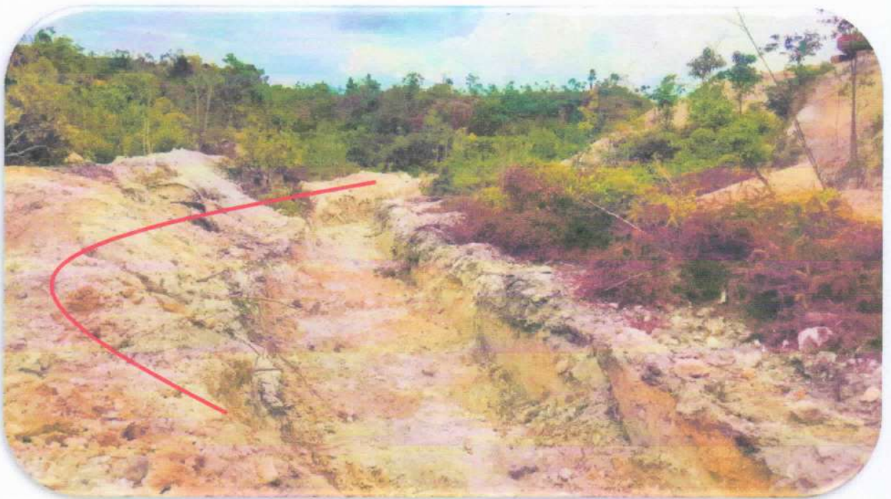
ภาพที่ 11-12 รูปภาพแสดงการจัดทำทางระบายน้ำให้แข็งแรง เพื่อป้องกันการกัดเซาะคันดินชะล้างสู่ชุมชนตาม แนวเขตประทานบัตร
