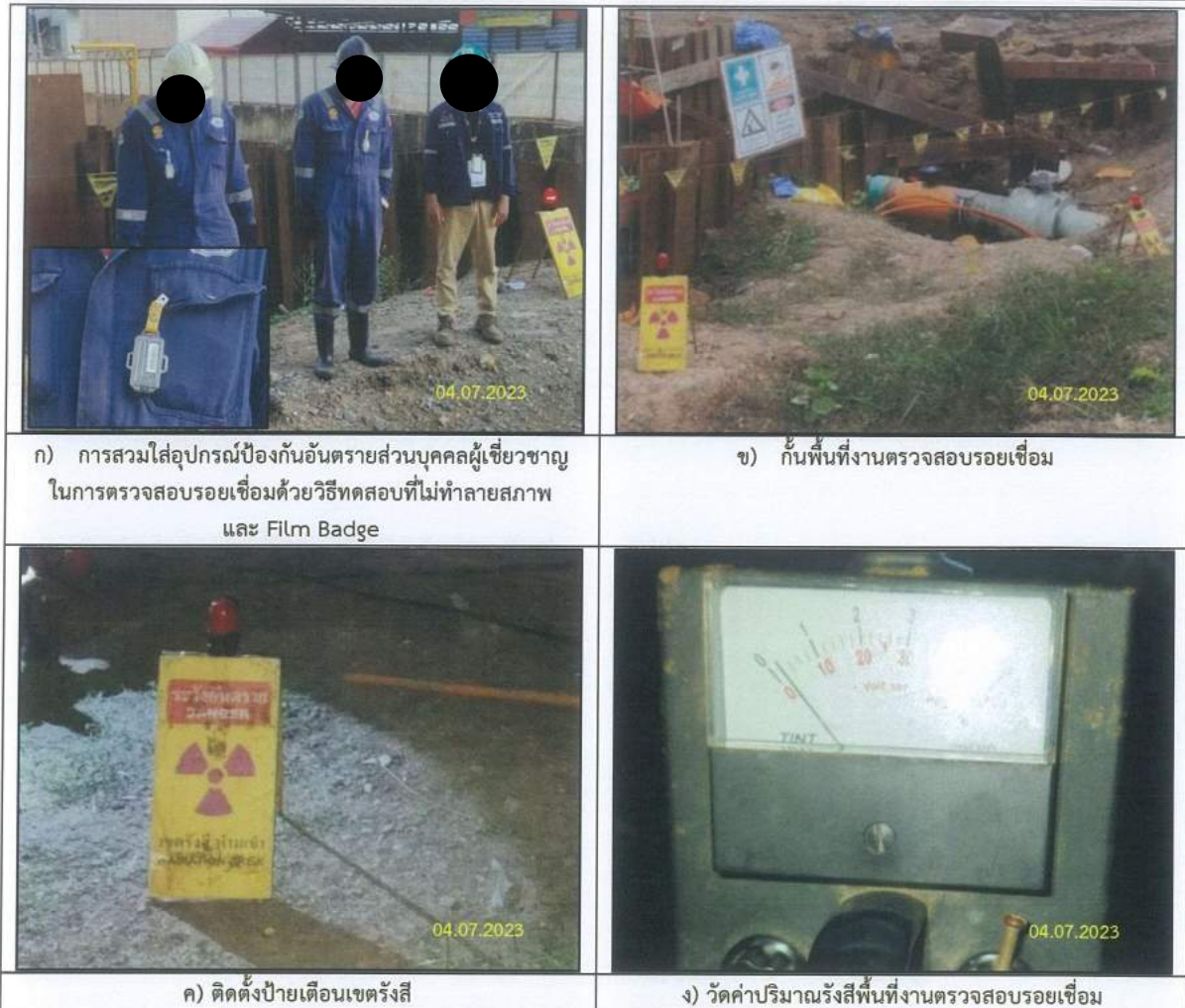
รูปที่ 2-29 การปฏิบัติด้านสุขภาพ อาชีวอนามัย และความปลอดภัย การป้องกันและแก้ไขผลกระทบช่วงงานตรวจสอบรอยเชื่อม
