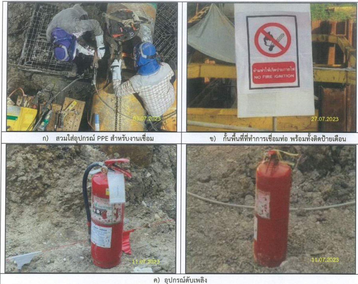
รูปที่ 2-28 การปฏิบัติด้านสุขภาพ อาชีวอนามัย และความปลอดภัย การป้องกันและแก้ไขผลกระทบช่วงงานเชื่อมท่อส่งก๊าซธรรมชาติ
