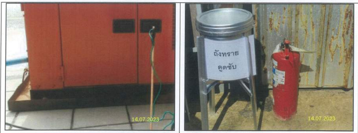
รูปที่ 2-14 การจัดเตรียมภาคเก็บรองรับน้ำมัน และวัสดุดุดจับ
