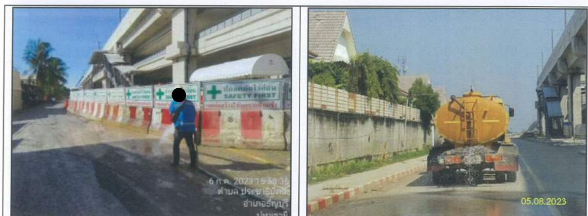
รูปที่ 2-2 การฉีดพรมน้ำบริเวณพื้นที่ก่อสร้างและเส้นทางคมนาคมในบริเวณใกล้เคียงพื้นที่ก่อสร้าง
