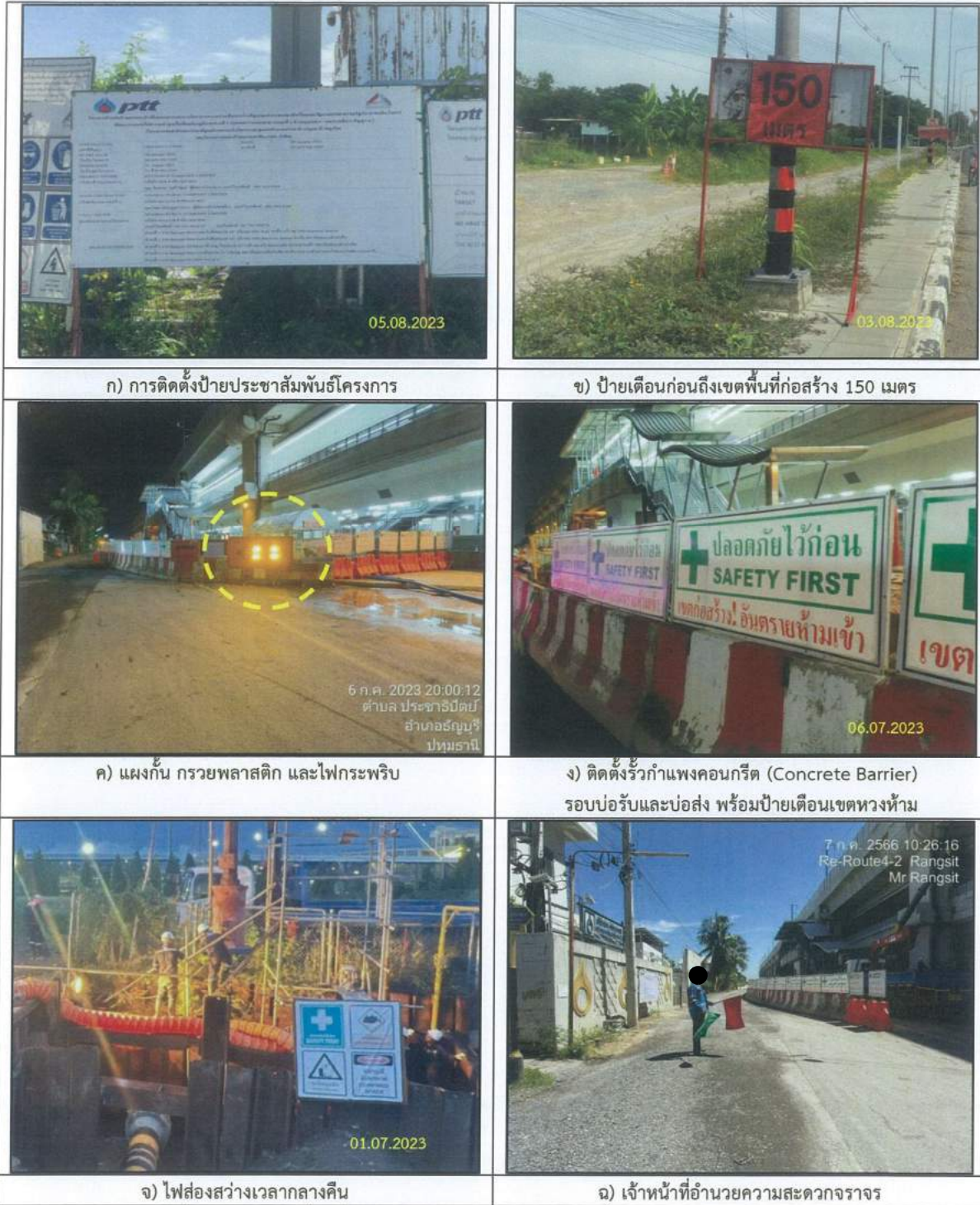
รูปที่ 2-18 การติดตั้งเครื่องหมายจราจร ป้ายเตือน แผงกัน กรวยพลาสติก ไฟกระพริบ และเจ้าหน้าที่อำนวยความสะดวกด้านการจราจร
