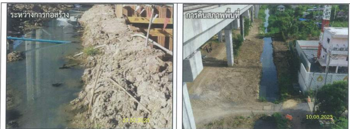
รูปที่ 2-17 การทำทางเบี่ยงเบนทิศทางการไหลของน้ำชั่วคราว และการปรับคืนสภาพพื้นที่
