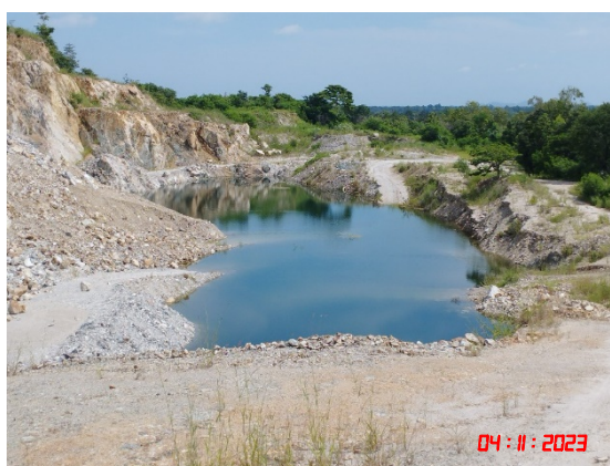
รูปที่ 12 บ่อรับน้ำ (Sump) บริเวณพื้นที่ทำเหมือง
