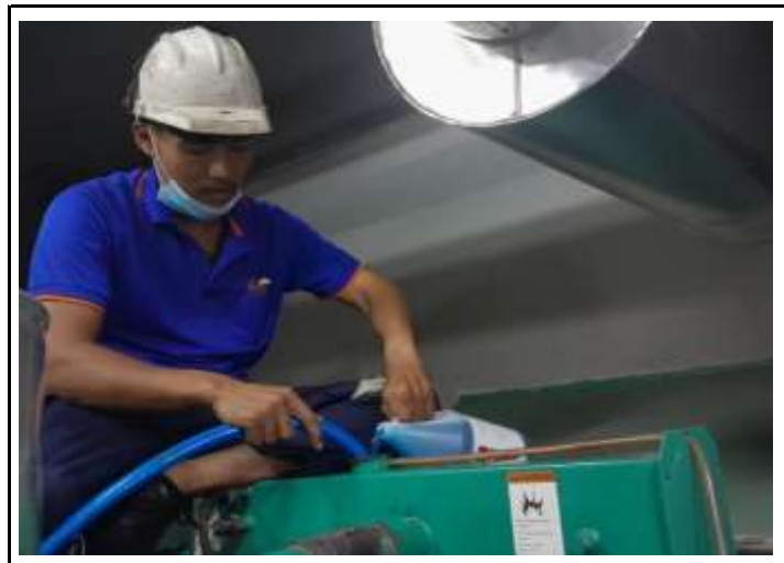
ทำการเปลี่ยนกรองน้ำมันเชื้อเพลิงใหม่ และเปลี่ยนถ่าย,เติมน้ำยาหล่อเย็นเครื่องกำเนิดไฟฟ้า
