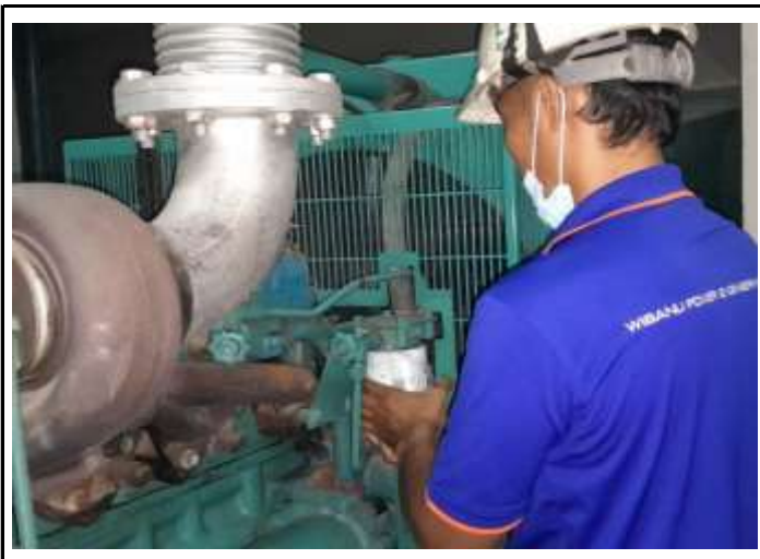
ทำการเปลี่ยนกรองน้ำมันเชื้อเพลิงใหม่ และเปลี่ยนถ่าย,เติมน้ำยาหล่อเย็นเครื่องกำเนิดไฟฟ้า
