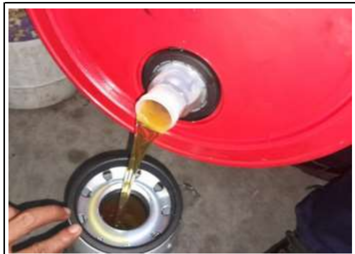
ทำการเปลี่ยนกรองน้ำมันเครื่องกำเนิดไฟฟ้า ( Generator )
