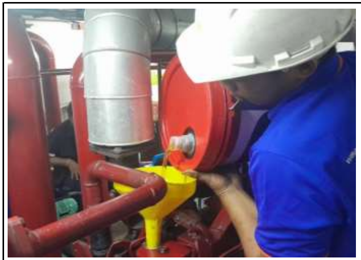
ทำการเปลี่ยนถ่ายและเติมน้ำมันเครื่องยนต์ Fire Pump
