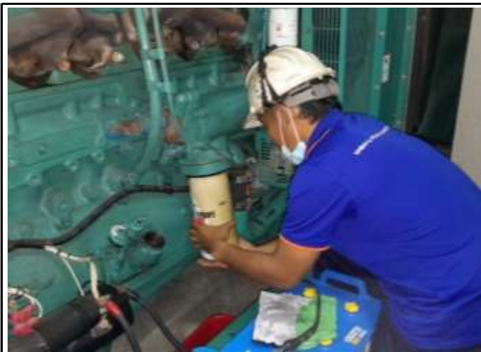
ทำการเปลี่ยนกรองน้ำมันเครื่องกำเนิดไฟฟ้า ( Generator )
