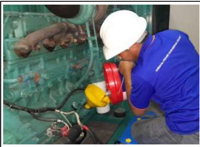
ทำการเปลี่ยนถ่ายและเติมน้ำมันเครื่อง Generator
