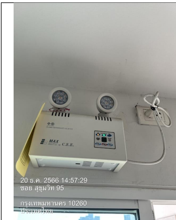
รูปที่ 2.4.5-3 ไฟฉุกเฉิน ขนาด 12 V ช่างอาคารฯตรวจเช็คเป็นประจำทุกเดือน
