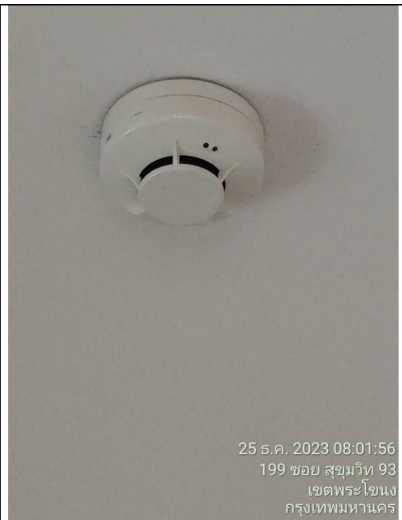
รูปที่ 2.4.6-6 อุปกรณ์ตรวจจับควันและความร้อน
