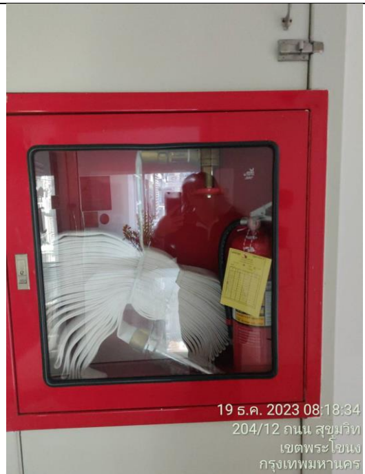
รูปที่ 2.4.6-2 ตู้เก็บสายน้ำดับเพลิงพร้อมอุปกรณ์
