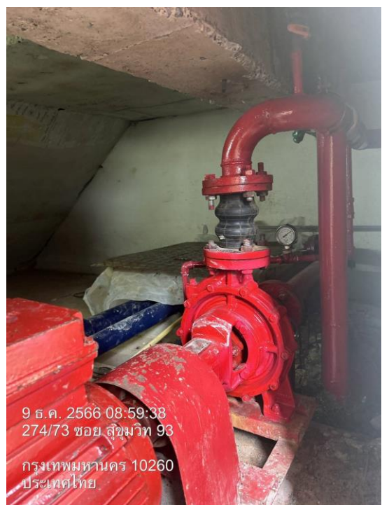
รูปที่ 2.4.6-4 ปั้มน้ำดับเพลิง
