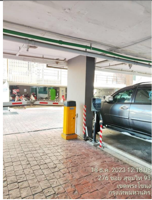
รูปที่ 2.4.11-4 ระบบควบคุมเข้าออกลานจอดรถ
