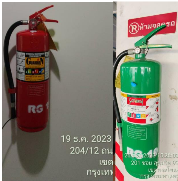
รูปที่ 2.4.6-3 ดับเพลิงมือถือ ชนิด ABC ขนาด 10 ปอนด์
