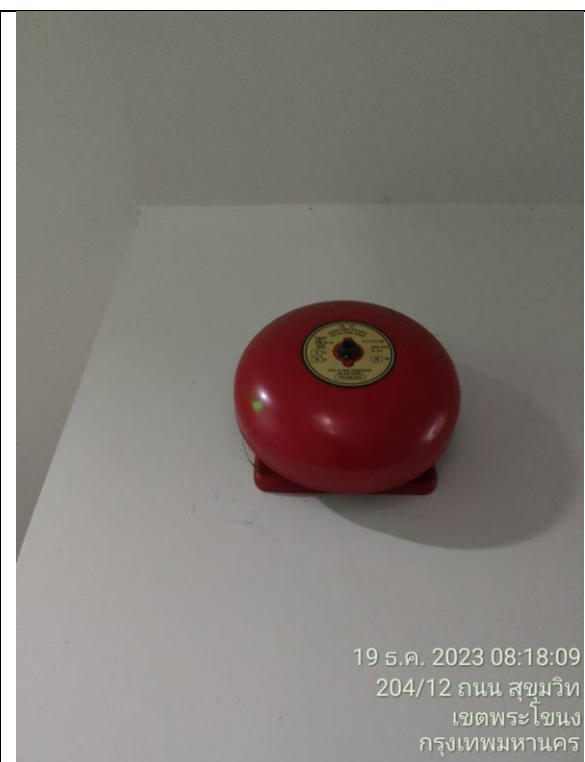
รูปที่ 2.4.6-8 กริ่งสัญญาณเตือนภัย
