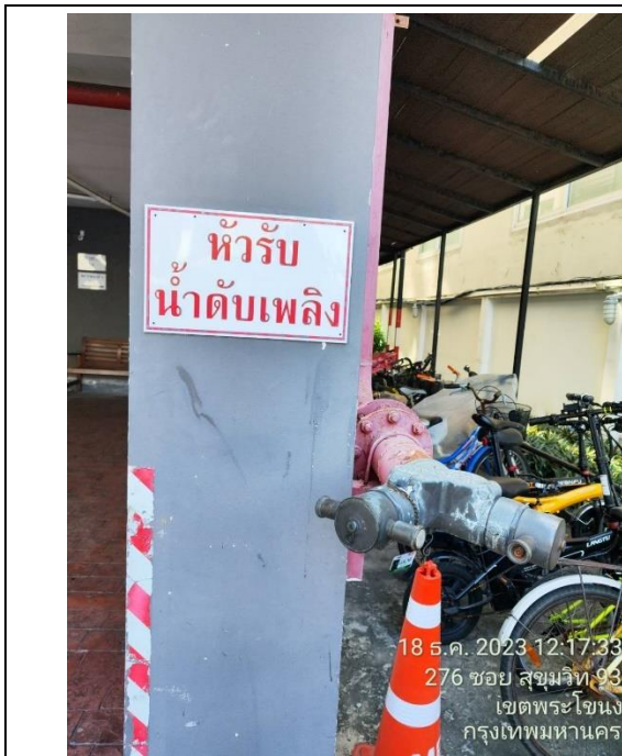
รูปที่ 2.4.6-1 ห้รับน้ำดับเพลิงภายนอกอาคาร
