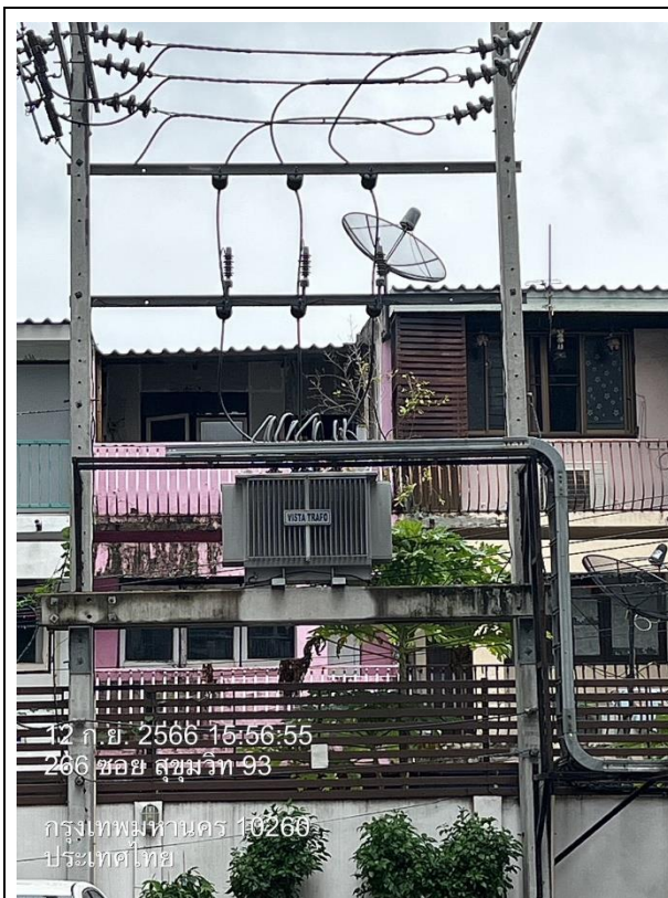
รูปที่ 2.4.5-1 หม้อแปลงไฟฟ้า ชุดที่ A
