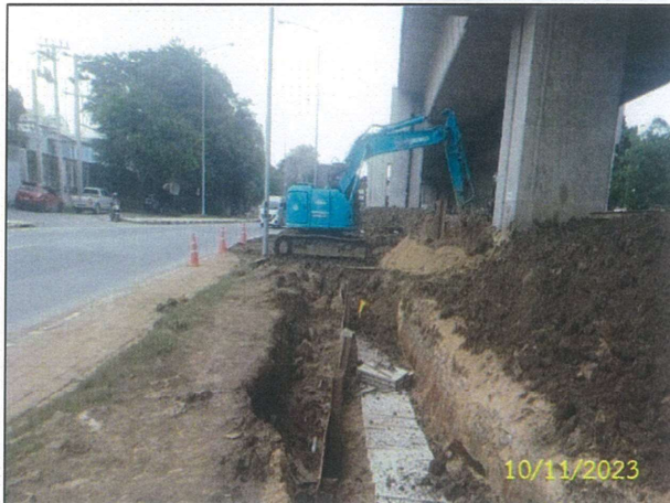
บริเวณ SECTION 1 : Open Cut 4.1 ค) กิจกรรมการวางแผ่นคอนกรีต (Concrete Slab)
