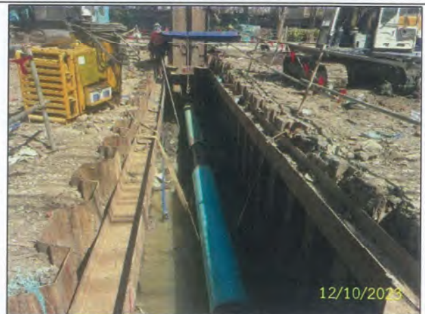
ก) การติดตั้ง Sheet Pile ในพื้นที่ที่มีความเสี่ยงด้านดินถล่ม
