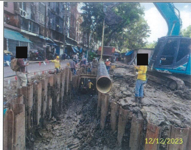
บริเวณ SECTION 1: Boring 1 ข) กิจกรรมการวางท่อสู่อ่งขุด (Trenching)
