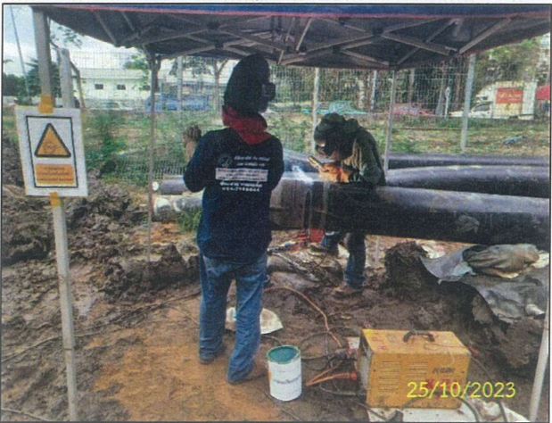
บริเวณ SECTION 1: Open Cut 4.1 จ) กิจกรรมการเชื่อมต่อและการตรวจสอบรอยเชื่อม (Welding and Weld Inspection)
