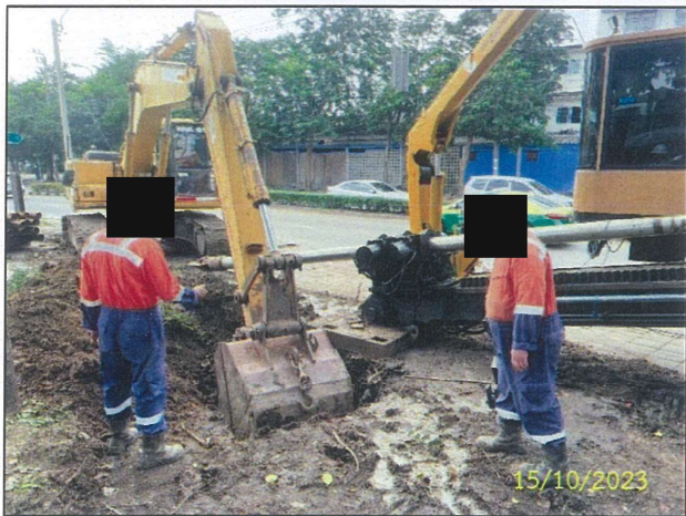
บริเวณ SECTION 1 : HDD 4 ค) กิจกรรมการขุดเปิด (Open Cut)
