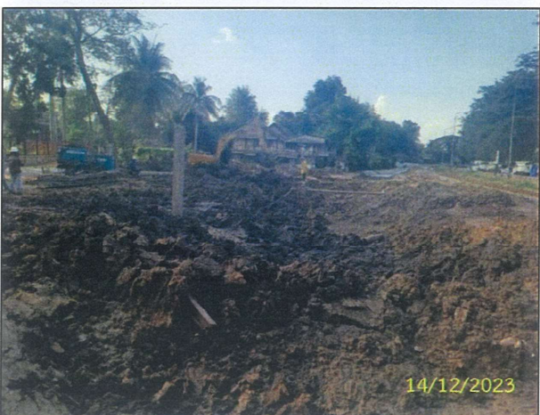
บริเวณ SECTION 1: HDD 3 จ) กิจกรรมการกลบท่อ (Backfilling)
