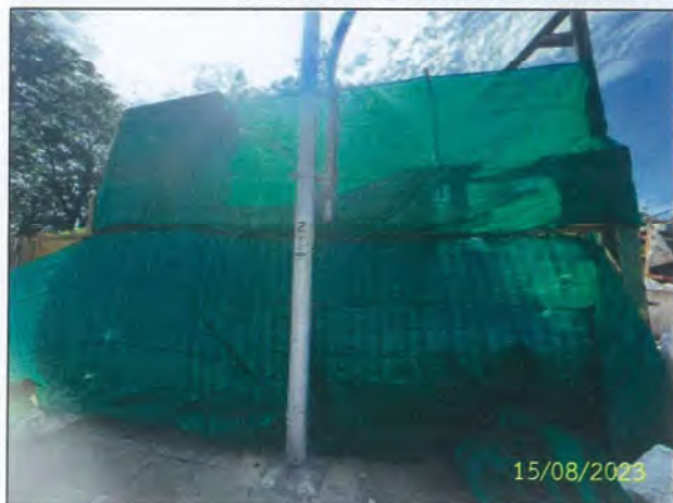
ฉ) ปิดปกคลุมบริเวณพื้นที่ผสมโซเดียมเบนโทไนท์ เพื่อป้องกันฝุ่นละออง รูปที่ 2-13 (ต่อ) การจัดการโคลนโซเดียมเบนโทไนท์ของโครงการ
