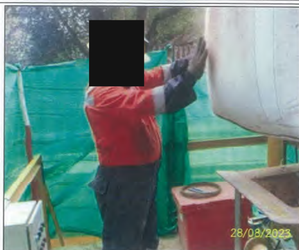
ง) เจ้าหน้าที่ผสมโซเดียมเบนโทไนท์เพื่อใช้ในการเจาะลอด
