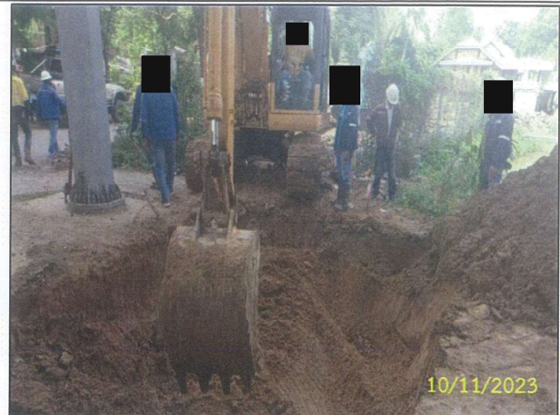
บริเวณ SECTION 1: HDD 3 ข) กิจกรรมการขุดเปิด (Open Cut)
