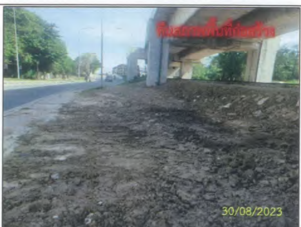
รูปที่ 2-4 การเปิดหน้าดินเป็นช่วงๆ ให้เพียงพอสำหรับการก่อสร้างและดำเนินการฝังกลบทันทีเมื่อวางท่อแล้วเสร็จ
