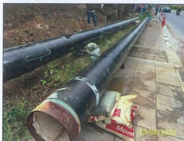
ข) การจัดวางท่อขนส่งน้ำมันบนวัสดุรองรับ
