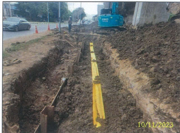
บริเวณ SECTION 1 : Open Cut 4.1 ง) กิจกรรมการวางแถบสีเหลือง (Warning Tape)
