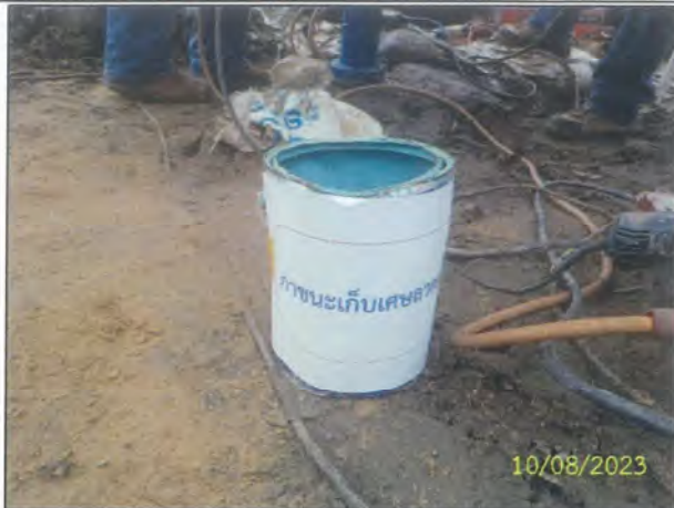
ง) ภาชนะสำหรับจัดเก็บเศษโลหะป้องกันประกายไฟไปสัมผัสกับวัสดุติดไฟ รูปที่ 2-29 (ต่อ) การปฏิบัติตามมาตรการฯ ในกิจกรรมการเชื่อม
