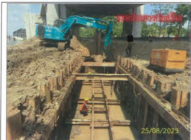
รูปที่ 2-4 การเปิดหน้าดินเป็นช่วงๆ ให้เพียงพอสำหรับการก่อสร้างและดำเนินการฝังกลบทันทีเมื่อวางท่อแล้วเสร็จ
