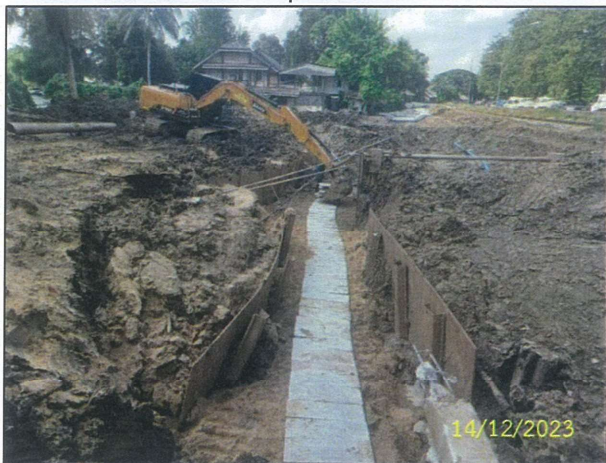
บริเวณ SECTION 1: HDD 3 ค) กิจกรรมการวางแผ่นคอนกรีต (Concrete Slab)
