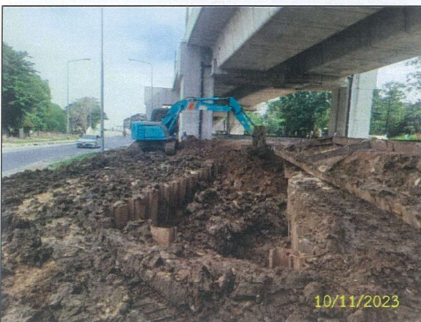
บริเวณ SECTION 1: Open Cut 4.1 จ) กิจกรรมการกลบท่อ (Backfilling)
