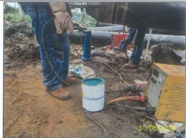
ง) ภาชนะสำหรับจัดเก็บเศษโลหะป้องกันประกายไฟไปสัมผัสกับวัสดุติดไฟ รูปที่ 2-29 (ต่อ) การปฏิบัติตามมาตรการฯ ในกิจกรรมการเชื่อม
