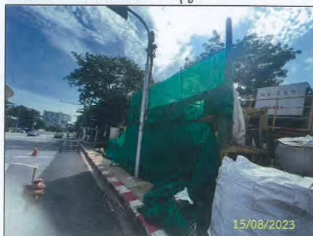
ฉ) ปิดปกคลุมบริเวณพื้นที่ผสมโซเดียมเบนโทไนท์ เพื่อป้องกันฝุ่นละออง รูปที่ 2-13 (ต่อ) การจัดการโคลนโซเดียมเบนโทไนท์ของโครงการ
