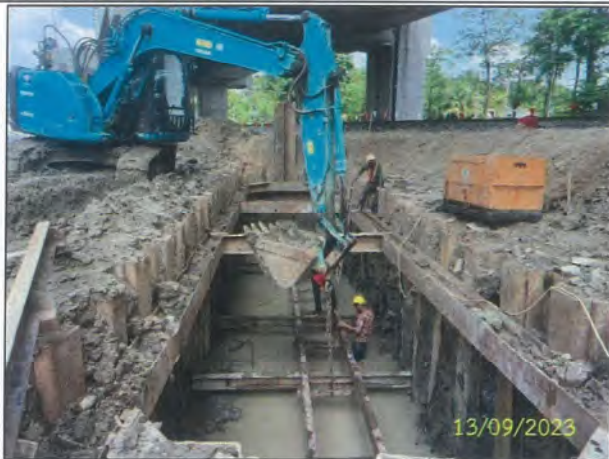
ก) การติดตั้ง Sheet Pile ในพื้นที่ที่มีความเสี่ยงด้านดินถล่ม
