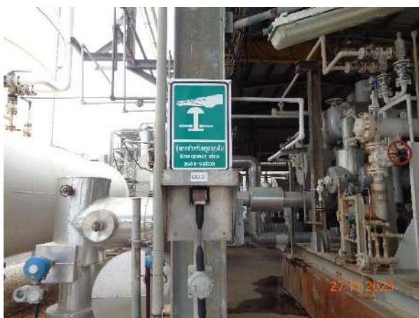
ภาพที่ 2.2-38 ปุ่มหยุดฉุกเฉินขณะ Load สารเคมี
