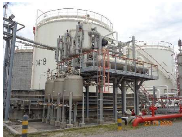
ภาพที่ 2.2-8 Vent Condensing Unit
