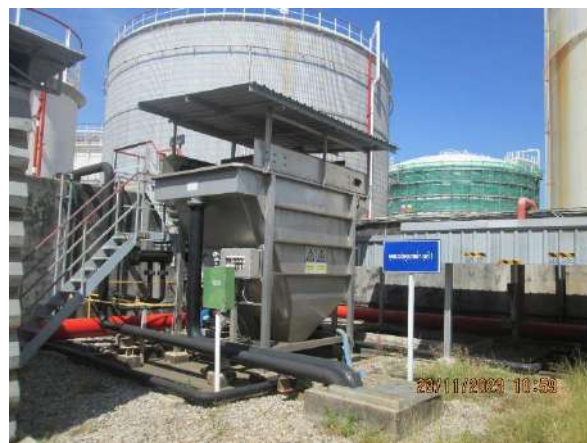
ภาพที่ 2.2-14 Oil-Water Separator
