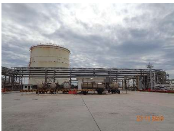
ภาพที่ 2.2-11 การจัดเตรียม Pre-Pumping เพื่อรวบรวมน้ำที่ปนเปื้อนเคมีภัณฑ์ไปกำจัดภายนอก
