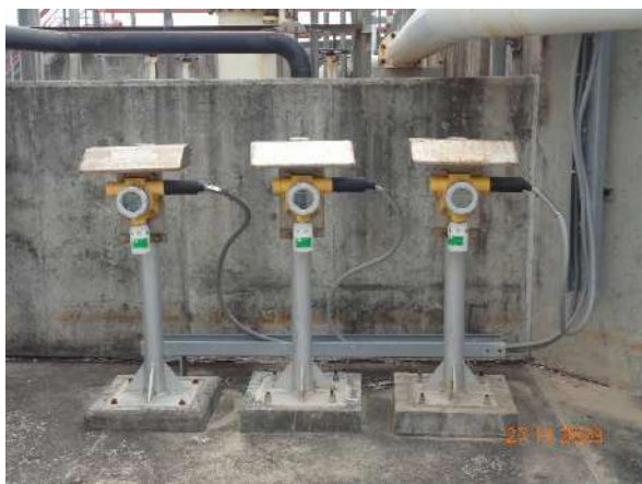
ภาพที่ 2.2-1 Gas Detector
