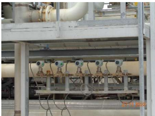
ภาพที่ 2.2-7 Pressure Transmitter
