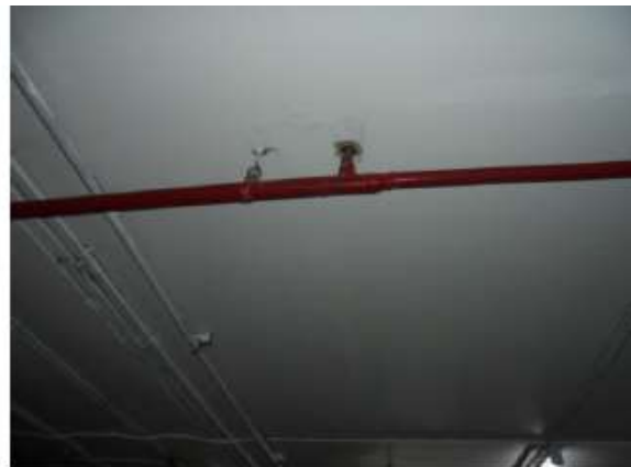
ภาพที่ 5-22 Smoke Detector และ Sprinkler
