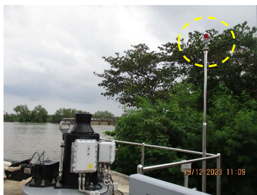
ภาพที่ 2-15 การติดตั้งสัญญาณไฟกระพริบบนท่าเทียบเรือของโครงการ
