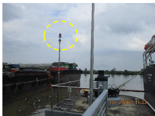
ภาพที่ 2-15 การติดตั้งสัญญาณไฟกระพริบบนท่าเทียบเรือของโครงการ
