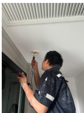
รูปที่ 44 เจ้าหน้าที่ตรวจสอบระบบสัญญาณแจ้งเหตุเพลิงไหม้
