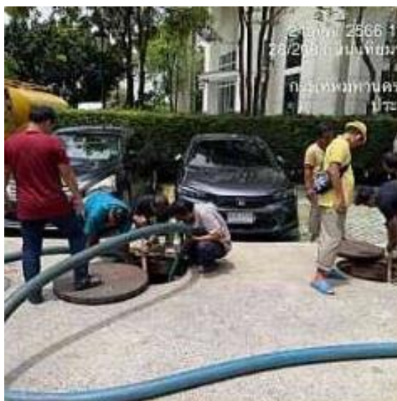
รูปที่ 13 ดำเนินการ ทำการตัดไขมันบำบัด อาคาร 1-3-5-8
