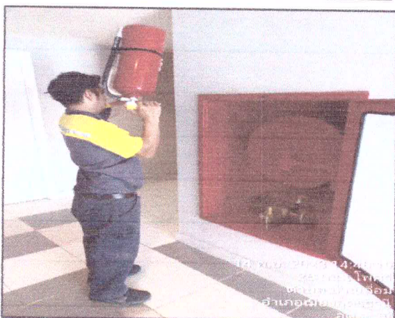
ตรวจเช็คถังดับเพลิง เดือน/ครั้ง
