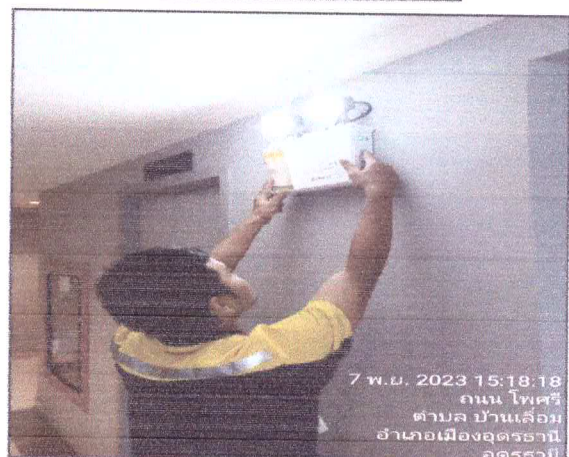
ตรวจเช็คไฟฉุกเฉิน เดือน/ครั้ง
