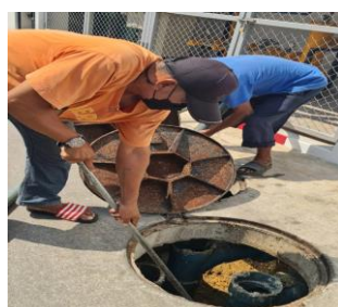
สูบลากตะกอนจากระบบบำบัดน้ำเสีย
