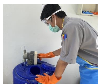
ระบบฆ่าเชื้อด้วยคลอรีนในน้ำทิ้งสุดท้าย
