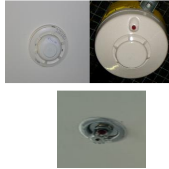
เครื่องตรวจจับควัน / ความร้อน และหัวกระจายน้ำดับเพลิง
