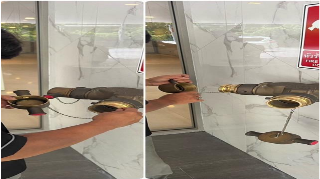
ภาคผนวกที่ 3-26 ตรวจสอบหัวรับน้ำดับเพลิง
