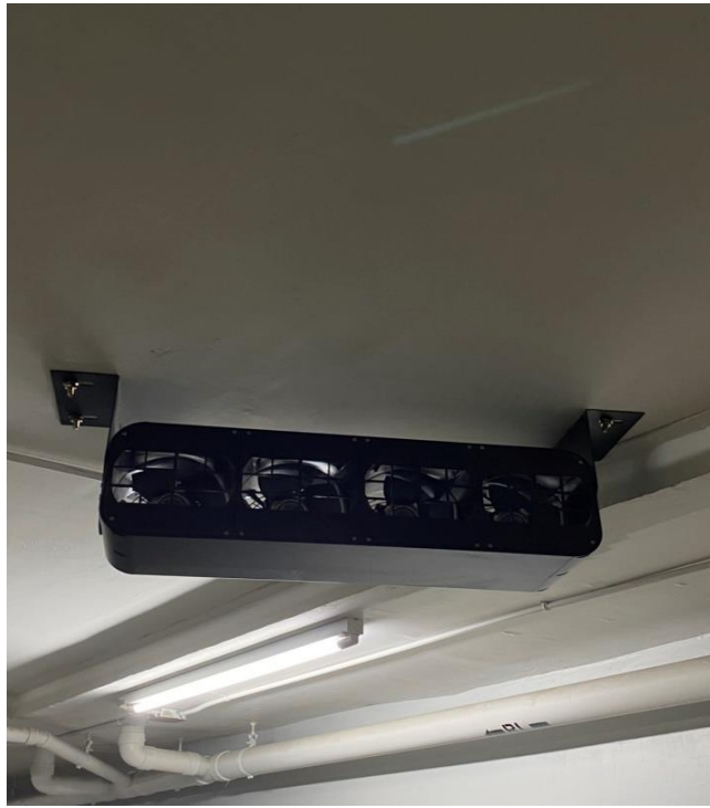
ภาคผนวกที่ 3-45 พัดลมระบายอากาศ
