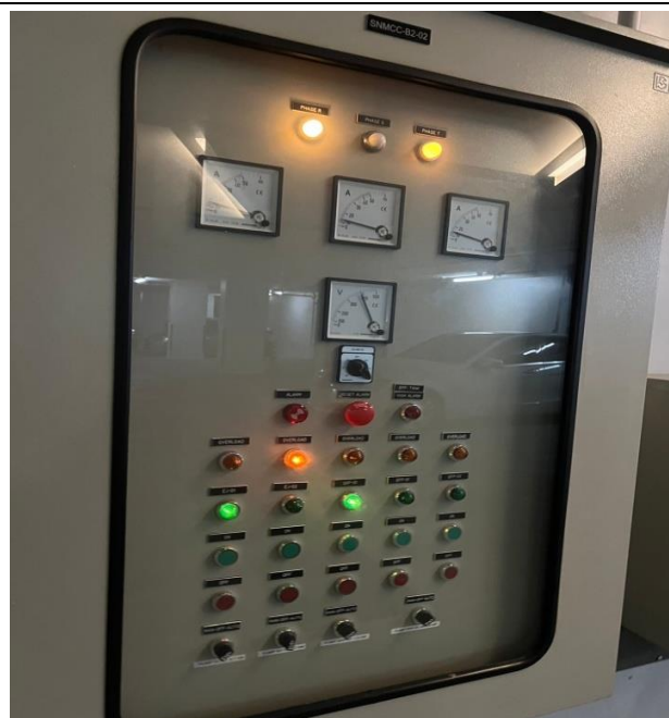
รูปที่ 2.4.3-2 ตู้ควบคุมระบบบำบัดน้ำเสีย
