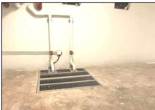
ภาพที่ 2-9 ป่อท่อน้ำและรางระบายน้ำ
