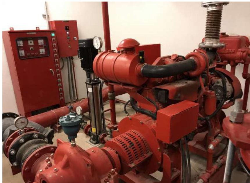
ภาพที่ 1-5 ปั้มน้ำดับเพลิง (Fire Pump)
