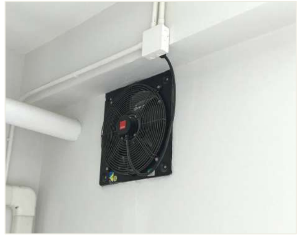
ภาพที่ 1-17 (ข) ระบบระบายอากาศด้วยวิธีกล
