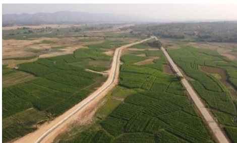
ภาพที่ 1.3 ความก้าวหน้าของระบบส่งน้ำพร้อมอาคารประกอบความยาว 10.777 กม.
