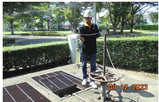
รูปที่ 3-1 การเก็บตัวอย่างน้ำจากระบบบำบัดน้ำเสีย
