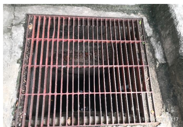
รูปที่ ก-13 ตะแกรงเหล็กปิดไว้ในท่อระบายน้ำรวม ของโครงการ
