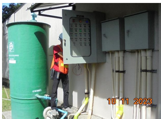
รูปที่ ก-13 ถังดักตะกอนฝอย
