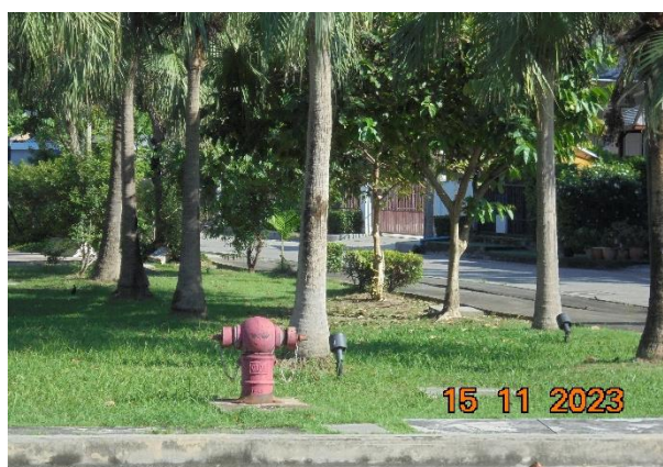
รูปที่ ก-21 ติดตั้งหัวจ่ายน้ำดับเพลิงให้ครอบคลุม พื้นที่ทั้งหมดของโครงการ
