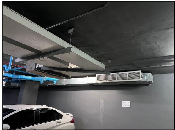
ระบบระบายอากาศในชั้นจอดรถใต้ดิน
