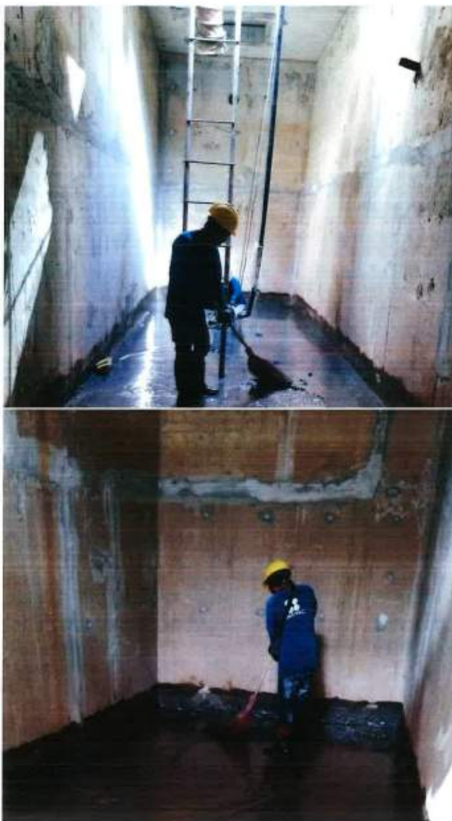
ภาพประกอบการทำงานทำความสะอาดใต้น้ำ
