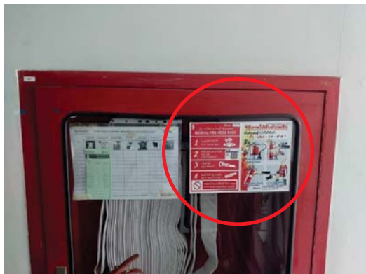
รูปที่ 19 ป้ายคำแนะนำการใช้งานอุปกรณ์ และการตรวจเช็คอุปกรณ์อัคคีภัย
