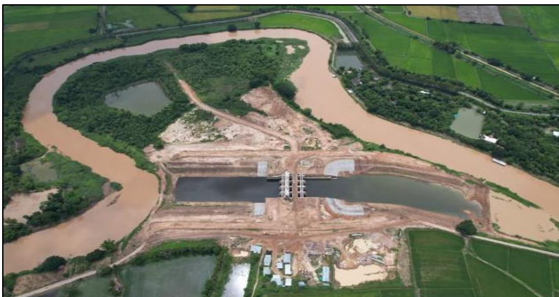
รูปที่ 1.6-1 การก่อสร้างประตูระบายน้ำและอาคารประกอบ
