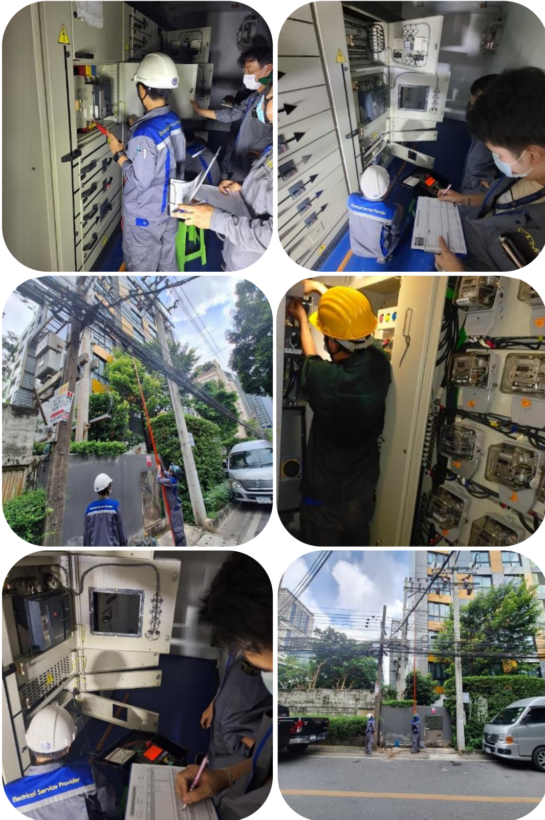
ภาพที่ 2-3.1.2 ตรวจสอบและบำรุงรักษาระบบไฟฟ้า หม้อแปลงไฟฟ้า และตู้ควบคุม MDB
