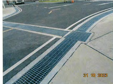
ภาพที่ 2-10 รางระบายน้ำฝนของโครงการ
