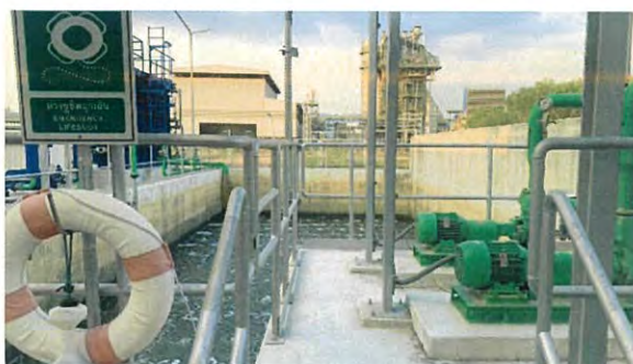
บ่อรวบรวมน้ำเสีย (Normal WasteWater Pond)
