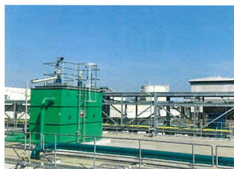
ระบบปรับสภาพน้ำทิ้ง (Neutralization Tank)
