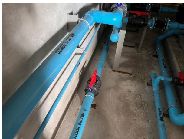
ภาพที่ 2-2 ป้ายแสดงตำแหน่งการเปิด-ปิดวาล์วต่างๆ
