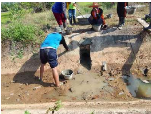
รูปที่ 5.1.5-1 ดำเนินการก่อสร้างซ่อมแซมอาคารท่อน้ำเข้านา และซ่อมแซมระบบส่งน้ำคลองดินแดง
