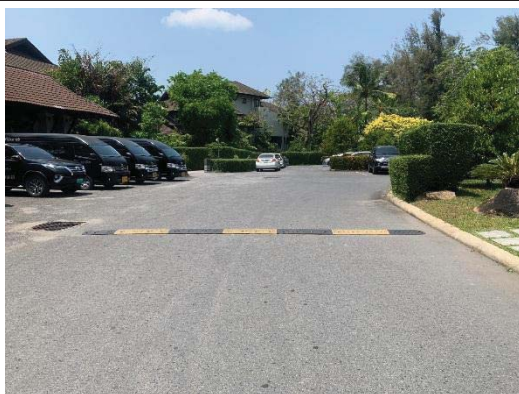
ภาพที่ 3 สันนุนยางชะลอความเร็วบริเวณทางเข้าลานจอดรถของโครงการ
