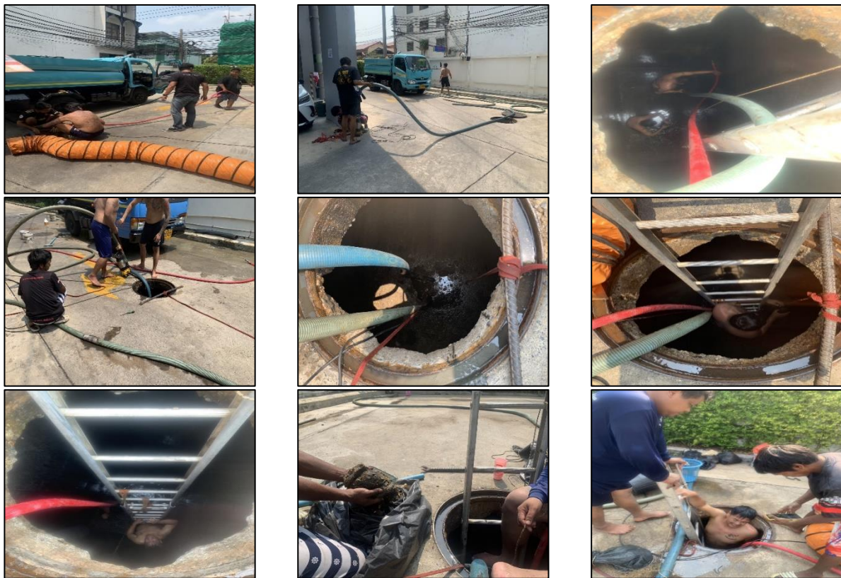
ภาพที่ 2.2-12 เจ้าหน้าที่ทำการสูบน้ำของระบบบำบัดน้ำเสีย
