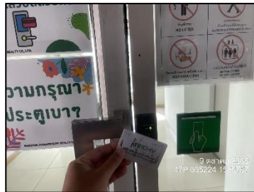
ภาพที่ 2.2-18 อุปกรณ์ควบคุมการเปิด-ปิดประตู
