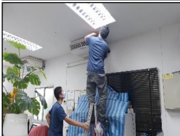
ภาพที่ 2.2-34 ล้างทำความสะอาดเครื่องปรับอากาศในพื้นที่ส่วนกลาง
