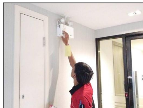
รูปภาพที่ 12 ตรวจสอบเช็คไฟฉุกเฉินประจำเดือน
