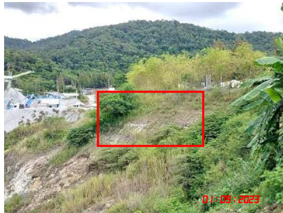
รูปที่ 16 การปลูกหญ้าแฝกบริเวณขึ้นบันไดที่ผ่านการทำเหมืองแล้ว
