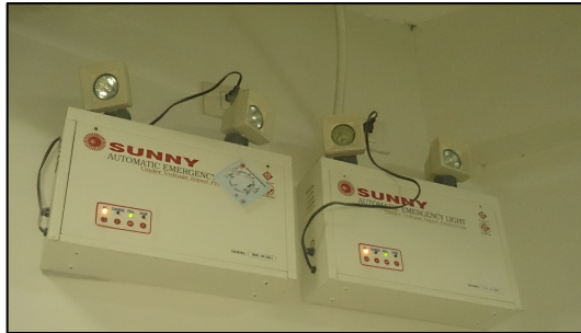
ภาพที่ 1-20 ไฟส่องสว่างฉุกเฉิน
