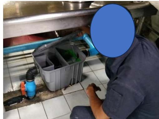
รูปที่ 2 การทำความสะอาดบ่อพักน้ำทิ้งและถังดักไขมัน
