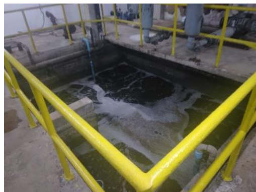
รูปที่ 2 การทำความสะอาดบ่อพักน้ำทิ้งและถังดักไขมัน
