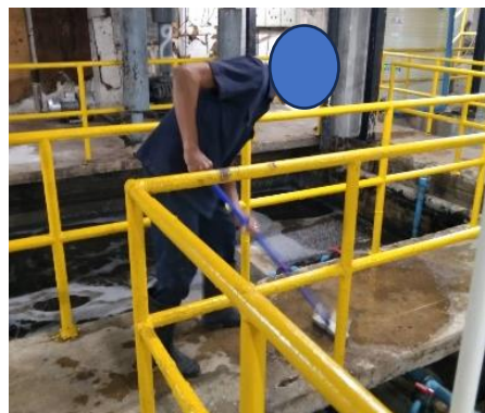
รูปที่ 4 การทำความสะอาดบ่อสูบน้ำเสีย และบ่อพักน้ำทิ้ง
