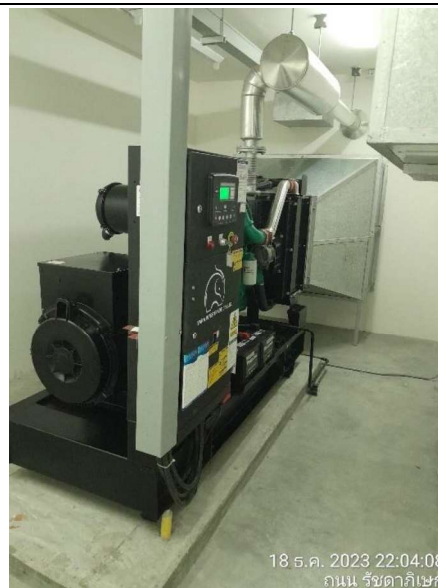
รูปที่ 2.4.5.2-1 เครื่องกำเนิดไฟฟ้าสำรอง
