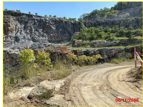
ภาพที่ 2-6 การปลูกพืชคลุมดิน และต้นไม้โตเร็วบริเวณคันทำนบ
