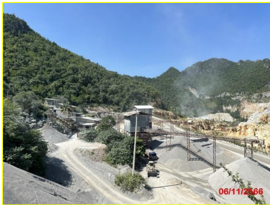
ภาพที่ 2-12 โรงโม่หินของโครงการปิดคลุม 3 ด้าน และการฉีดสเปรย์น้ำบริเวณปากโรงโม่
