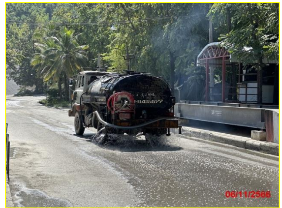
ภาพที่ 2-9 การฉีดพรมน้ำบริเวณเส้นทางลำเลียงขนส่งแร่
