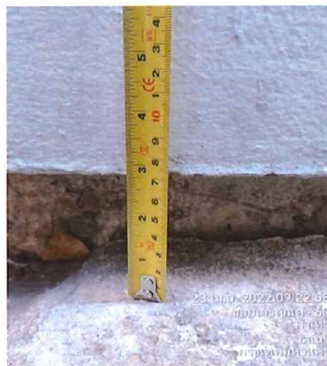
ระยะห่างของเสาและพื้นทางเดินที่ทรุดตัว 7.5 cm.
