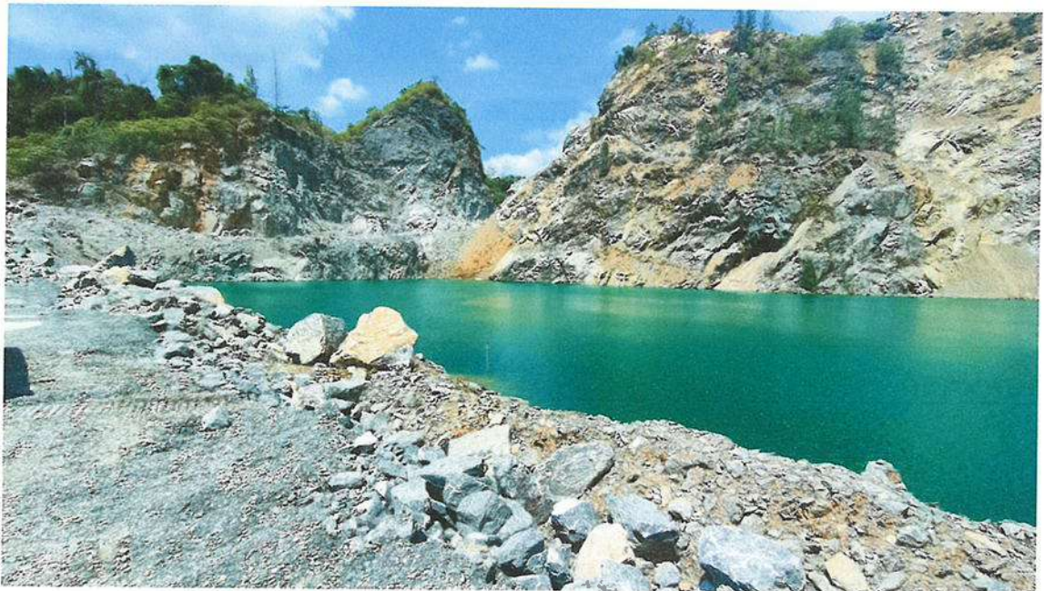
ขุมเหมืองเก่าใช้เป็นบ่อดักตะกอนเพื่อรองรับน้ำจากหน้าเหมืองช่วงหน้าฝน
