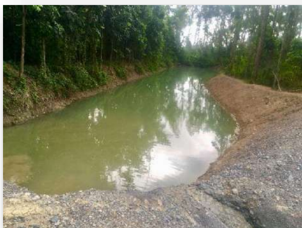
ภาพที่ 14 ภาพหลังการขุดลอกบ่อดักตะกอน แห่งที่ 3
