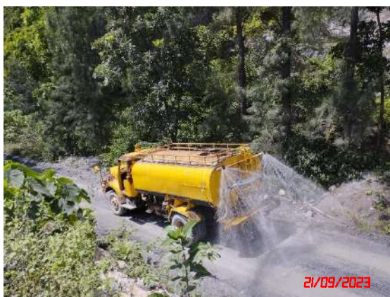
รูปที่ 8 การฉีดพรมน้ำ และการสเปรย์น้ำบริเวณพื้นที่โครงการ
