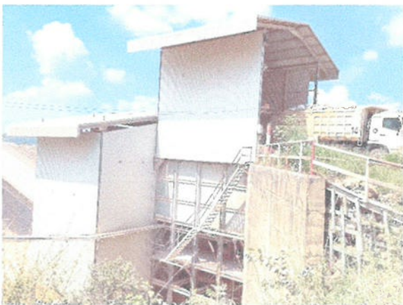
รูปที่ 15 การปิดคลุมอาคารโรงไม้หิน ชุด Hopper & Primary Crusher
