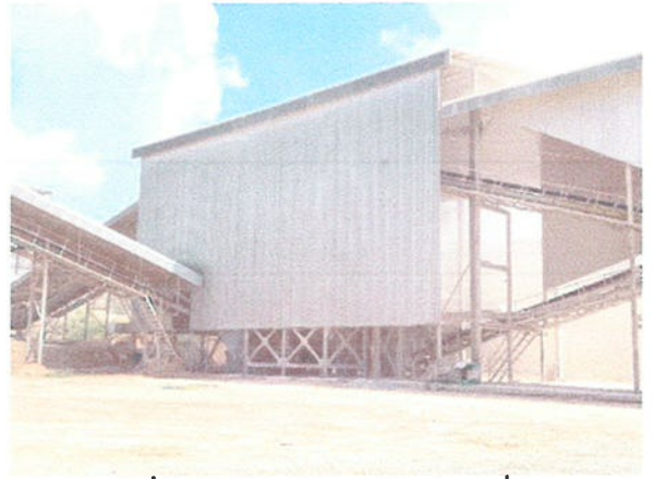
รูปที่ 16 การปิดคลุมอาคารโรงไม้หิน ชุด Secondary & Tertiary Crusher
