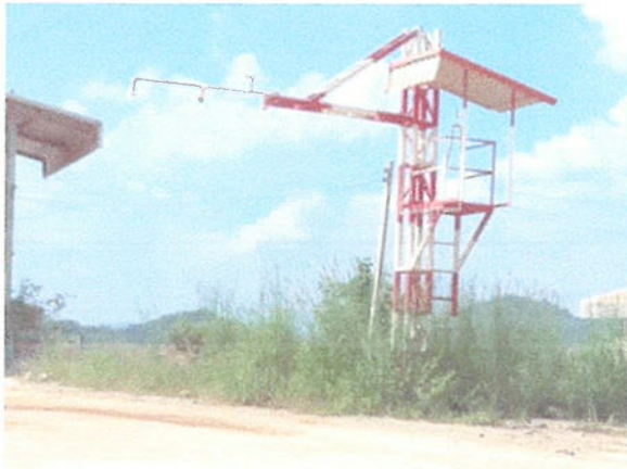
รูปที่ 19 ระบบสเปรย์น้ำบนกระบะรถบรรทุกหิน ก่อนเทหินลงปากโม
