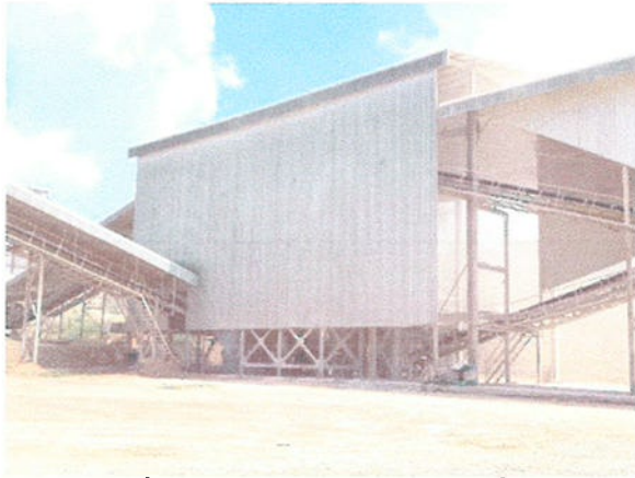
รูปที่ 13 การปิดคลุมอาคารโรงโม่หิน ชุด Secondary & Tertiary Crusher
