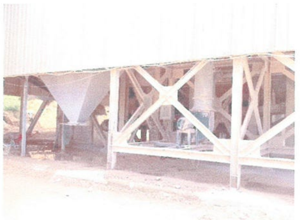
รูปที่ 18 เตรียมการติดตั้งระบบดูดฝุ่นละอองขณะ โม่หินแบบ Bag Filter
