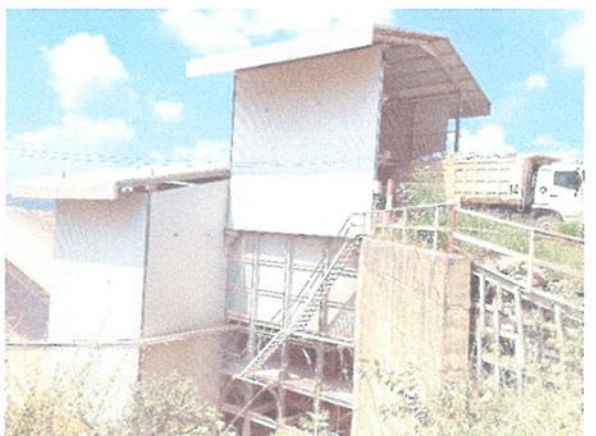
รูปที่ 12 การปิดคลุมอาคารโรงโม่หิน ชุด Hopper & Primary Crusher
