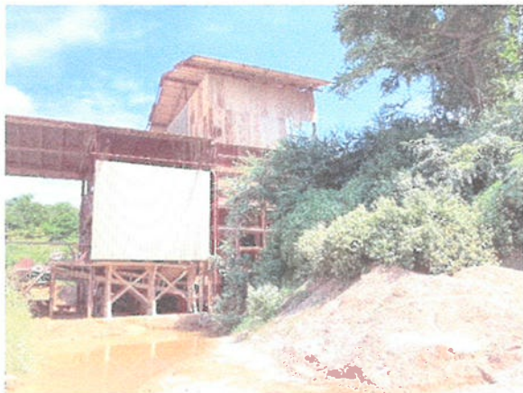
รูปที่ 13 การปิดคลุมอาคารโรงโม่หิน ชุด Hopper และ Primary Crusher
