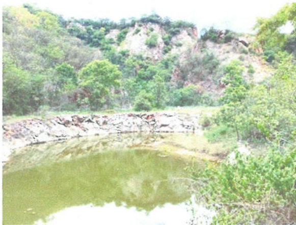
รูปที่ 7 Sump ที่ 2 รองรับน้ำขุ่นข้นและตะกอนดินที่เกิดจากการชะล้างบริเวณหน้าเหมือง
