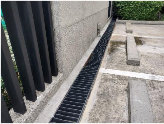
รูปที่ 37 ตะแกรงรางระบายน้ำ
