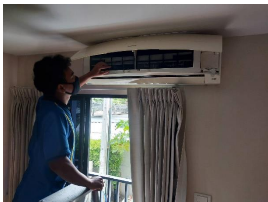
รูปที่ 71 เจ้าหน้าที่ทำการตรวจเช็คแผ่นกรอง อากาศ
