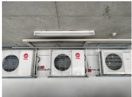
รูปที่ 8 คอนเดนเซอร์เครื่องปรับอากาศ
