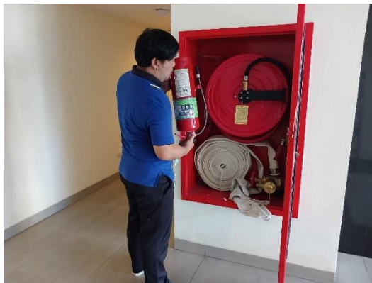
รูปที่ 51 การตรวจเช็คอุปกรณ์ดับเพลิง
