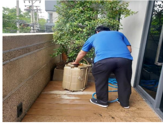
รูปที่ 78 ล้างเครื่องกรองน้ำสระว่ายน้ำ
