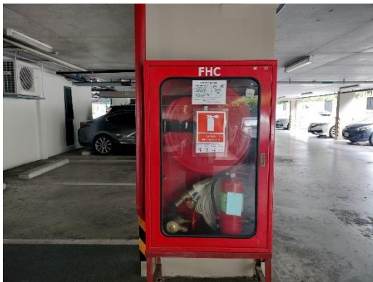
รูปที่ 45 ตู้เก็บสายดับเพลิง
