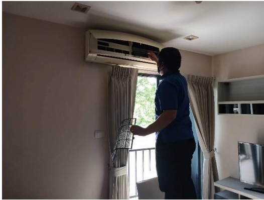
รูปที่ 7 ทำความสะอาดเครื่องปรับอากาศ
