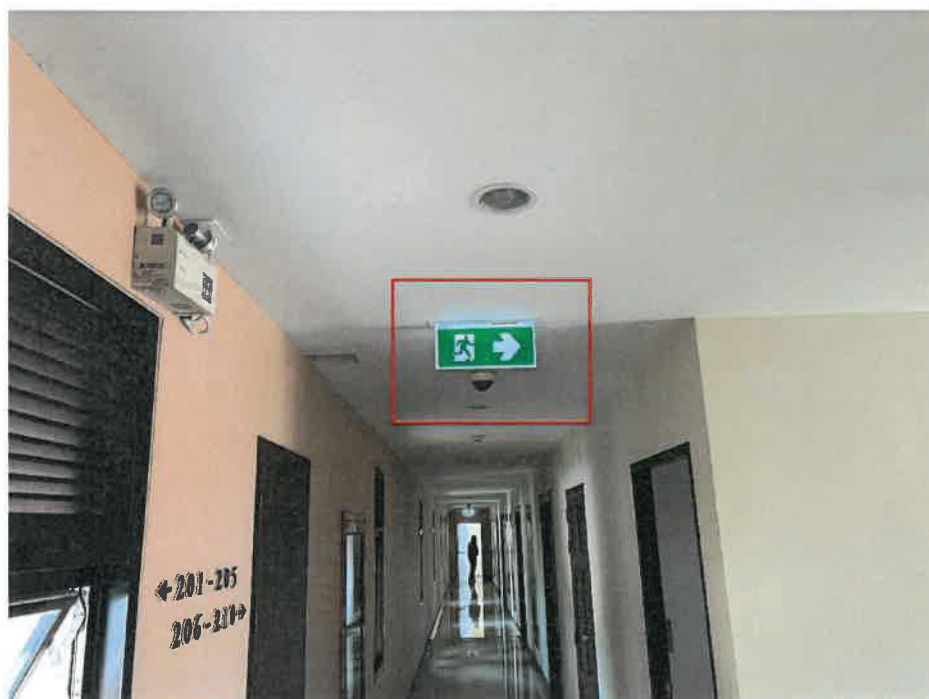
รูปที่ 3.2-36 ป้ายบอกทางหนีไฟ (Fire Exit Light)
