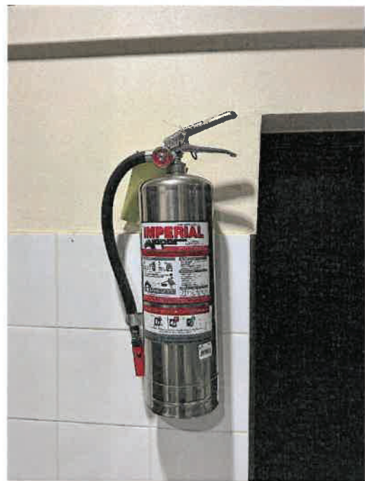
รูปที่ 3.2-33 ถังดับเพลิงเคมีชนิด A-B-C ขนาดความจุ 10 ปอนด์
