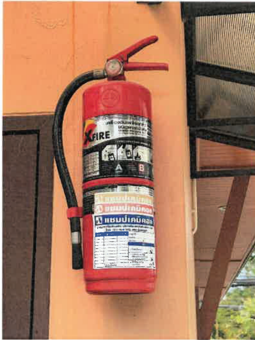
รูปที่ 3.2-33 ถังดับเพลิงเคมีชนิด A-B-C ขนาดความจุ 10 ปอนด์
