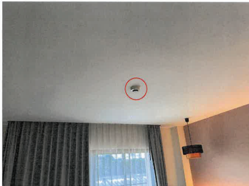
รูปที่ 3.2-34 เครื่องตรวจจับควัน (Smoke Detector)
