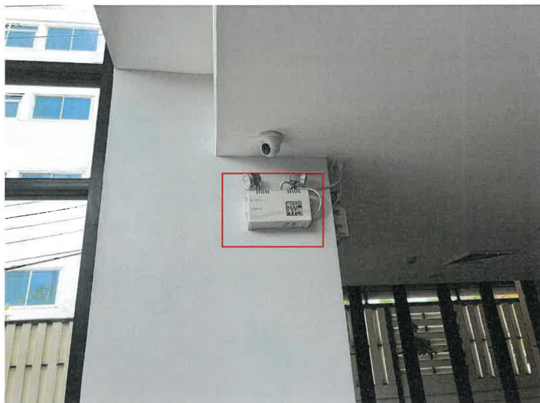
รูปที่ 3.2-35 ไฟส่องสว่างฉุกเฉิน (Emergency Light)
