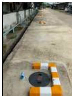
รูปที่ 24 ถังบำบัดน้ำเสียสำเร็จรูปแบบกระโถน-กรองไร้อากาศรองรับน้ำเสียจากบ้านพักนอกและอาคารเครื่องจักรกลการเกษตร
