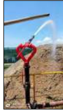
รูปที่ 71 ระบบดับเพลิงโดยรอบลานกองเก็บกากอ้อยและอาคารกองเก็บกากอ้อย
