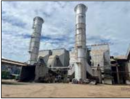
รูปที่ 78 หม้อไอน้ำติดตั้งระบบดักฝุ่นแบบไฟฟ้าสถิตต่ออนุกรมจากระบบมัลติไซโคลน
