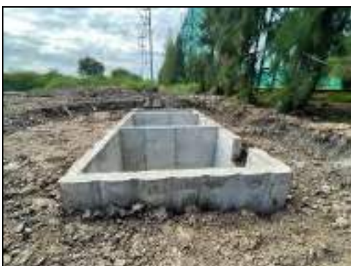
รูปที่ 76 บ่อตกตะกอนน้ำชะลานกองกากอ้อย
