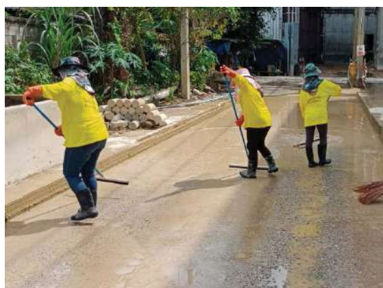
รูปที่ 13 ขุดลอกตะกอนในระบบระบายน้ำ
