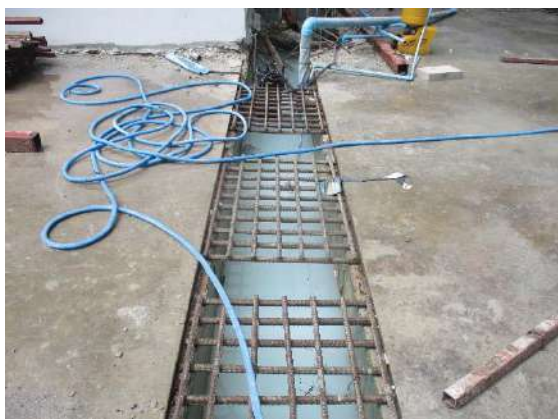
รูปที่ 10 จุดล้างล้อรถบรรทุก บริเวณทางเข้า-ออกของพื้นที่โครงการ
