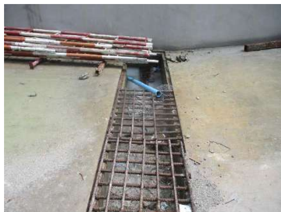
รูปที่ 10 จุดล้างล้อรถบรรทุก บริเวณทางเข้า-ออกของพื้นที่โครงการ
