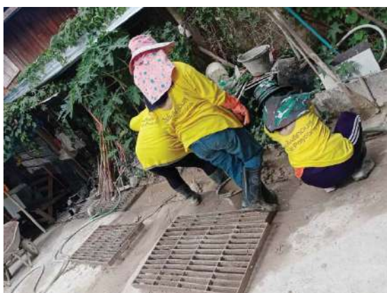
รูปที่ 13 ขุดลอกตะกอนในระบบระบายน้ำ
