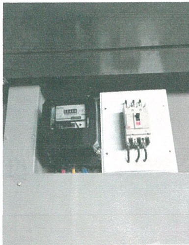
รูปภาพที่ 2.35 มิเตอร์ระบบบำบัดน้ำเสีย
