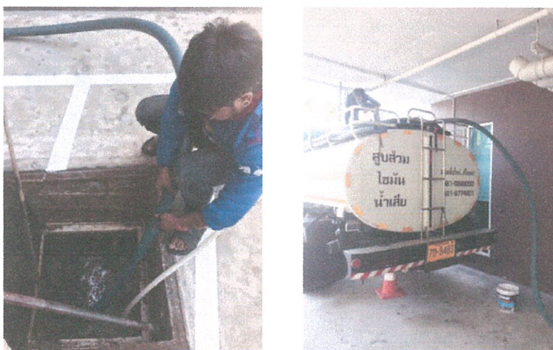
รูปภาพที่ 2.20 การสูบตะกอน
