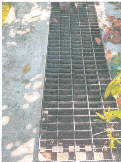
รูปภาพที่ 2.14 ตะแกรงดักขยะ
