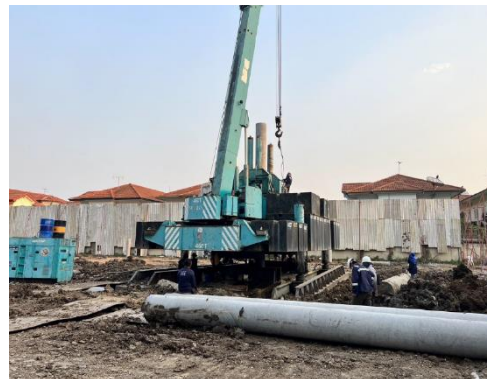
รูปที่ 16 เสาค้ำเข็มเจาะ
