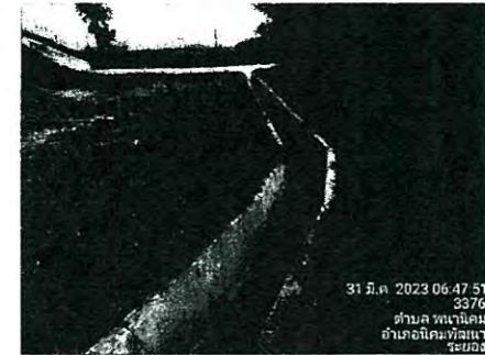
หลังบ่อพอน 2 มีดินสไลด์ลงรางระบายน้ำและรางระบายน้ำทรุด
