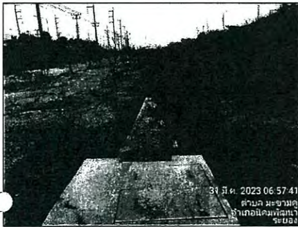
ด้านหลังแปลง J13 มีดินสไลด์ลงรางระบายน้ำฝน
